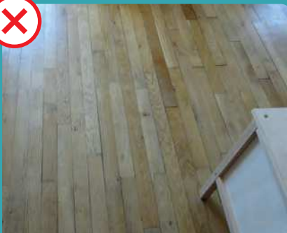
Plancher bois seul, sans chape béton
